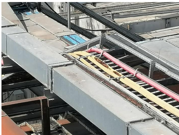
Slika 2 : Trasa 6kV kablova na cevnom mostu
