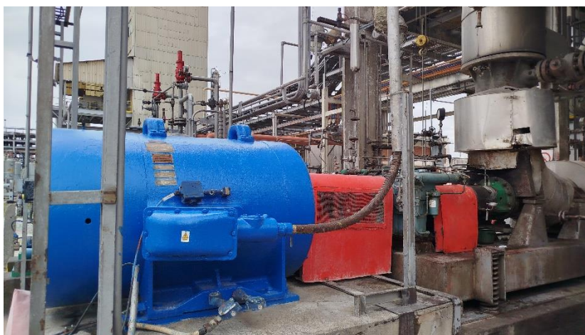
Slika 6 : Elektromotor 6kV bingam pumpe P-201
