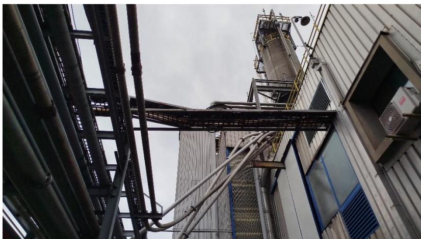
Slika 7 : Ulazak kablova u zgradu Dorade
