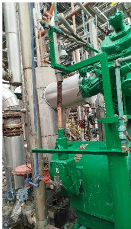
Slika 3 : Elektromotor kompresora 6kV
